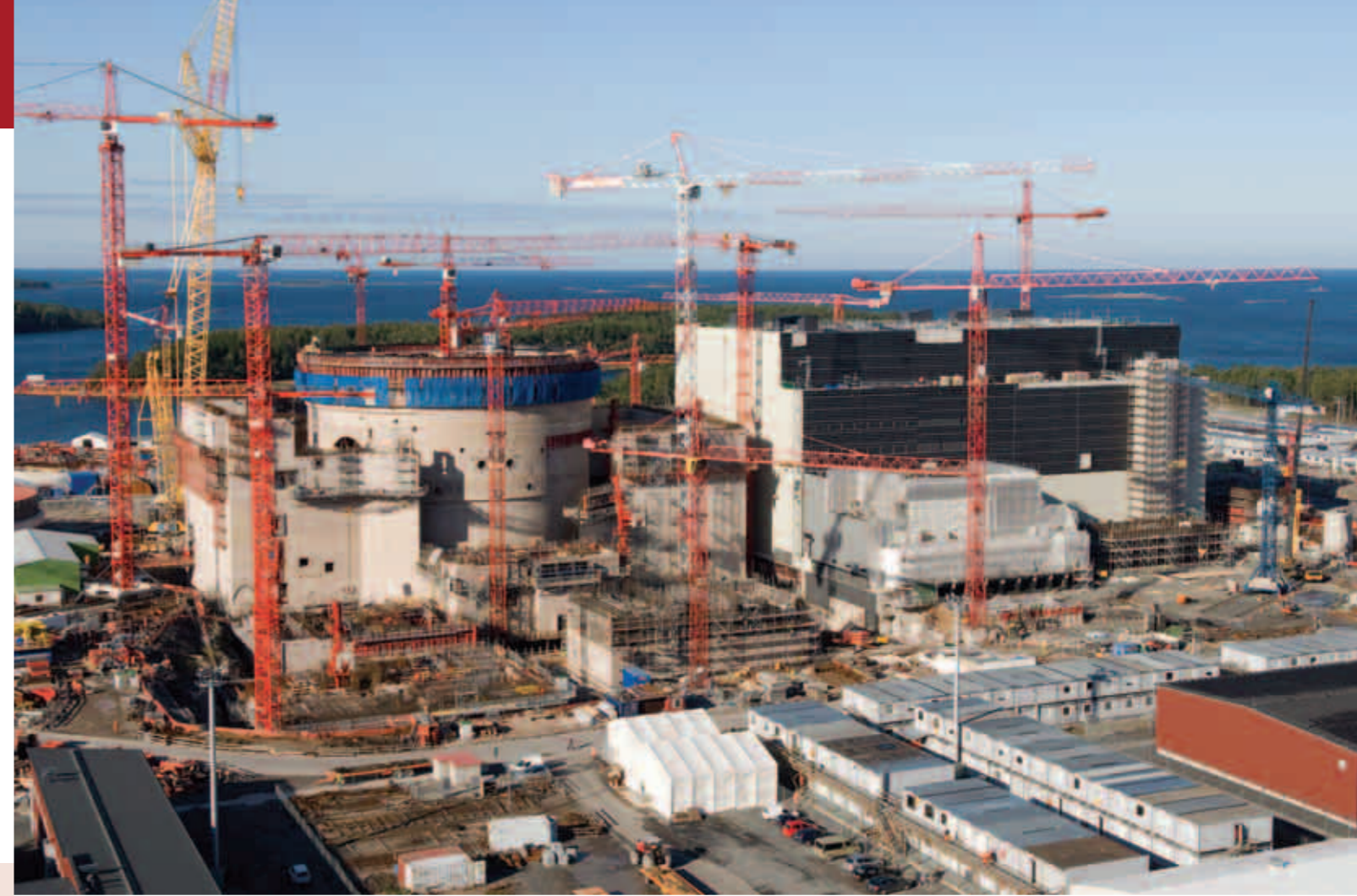
Строительство АЭС Олкилуото-3, Финляндия. Фото: AREVA/Пайви Бурдон.
